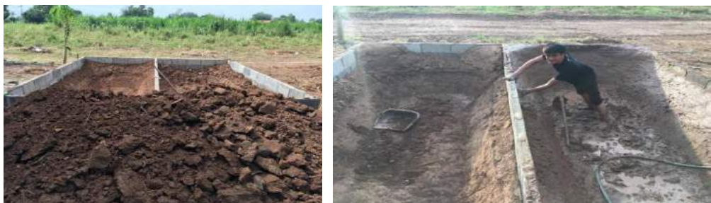
ภาพที่ 2 แสดงการนำดินที่ขุดขึ้นมาใช้เป็นฐานสำหรับวางวงบ่อซีเมนต์เพื่อทำบ่อเติมมูลสัตว์
