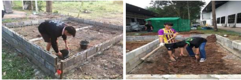
ภาพที่ 1 การเตรียมพื้นที่เพื่อก่ออิฐบล็อกความสูงจำนวนสองก้อน
