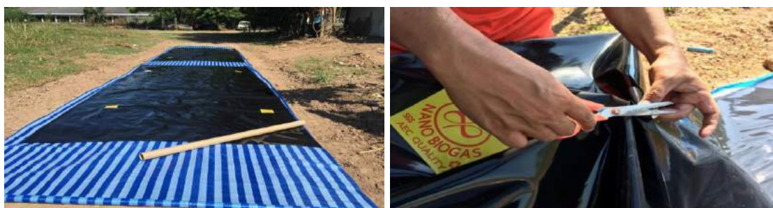
ภาพที่ 3 เตรียมวัสดุอุปกรณ์ประกอบถุงก๊าซและขั้นตอนการเจาะรูทางออกของก๊าซ
