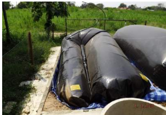
ภาพที่ 12 แสดงภาพถังก๊าซชีวภาพขนาด 8 ลบ.เมตร แบบมีการกดทับถุงและไม่มีแรงกดทับถุงก๊าซ
