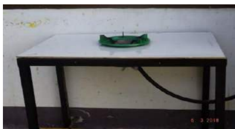
ภาพที่ 8 แสดงภาพของลักษณะหัวเตาก๊าซที่ติดตั้งเสร็จสมบูรณ์ และชุดระบายน้ำ
