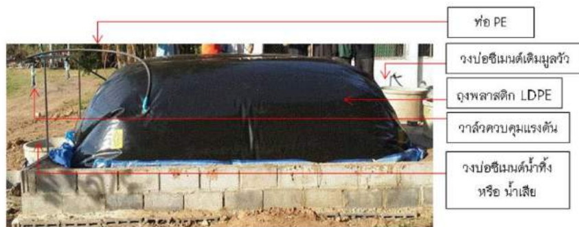
ภาพที่ 9 แสดงภาพบ่อก๊าซชีวภาพที่เสร็จสมบูรณ์
