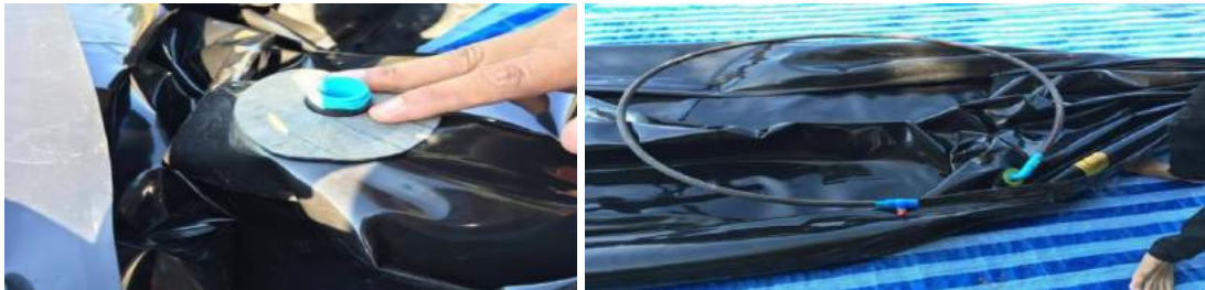
ภาพที่ 4 ขั้นตอนการต่อท่อทางออกก๊าซและนำท่อ PE มาสวมกับข้อต่อ 90 องศาเพื่อเป็นท่อส่งก๊าซไปยังวาล์ว
